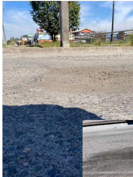
Bache Avda. Estación 5 , 1.00x1.00m. Intersección Avda. Estación – O. Jara Wolff. (1.00m 2 ).
