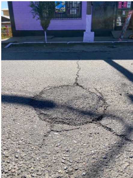
Bache Avda. Estación 4 , 1.00x1.00m. Intersección Avda. Estación-O. Jara Wolff. (1.00m 2 ).
