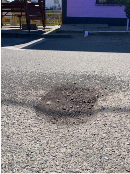
Bache Avda. Estación 5 , 1.00x1.00m. Intersección Avda. Estación – O. Jara Wolff. (1.00m 2 ).
