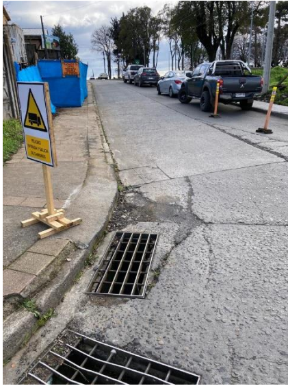
Bache intersección Freire-Lastra , 2.00x2.00m (4.00m 2 ).
