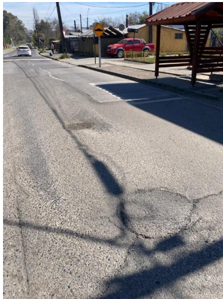
Bache Avda. Estación 4 , 1.00x1.00m. Intersección Avda. Estación-O. Jara Wolff. (1.00m 2 ).
