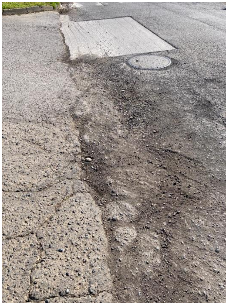
Bache A. Alessandri , 3.00x5.00. Intersección Calles A. Alessandri-Las Rosas (15.00m 2 ).
