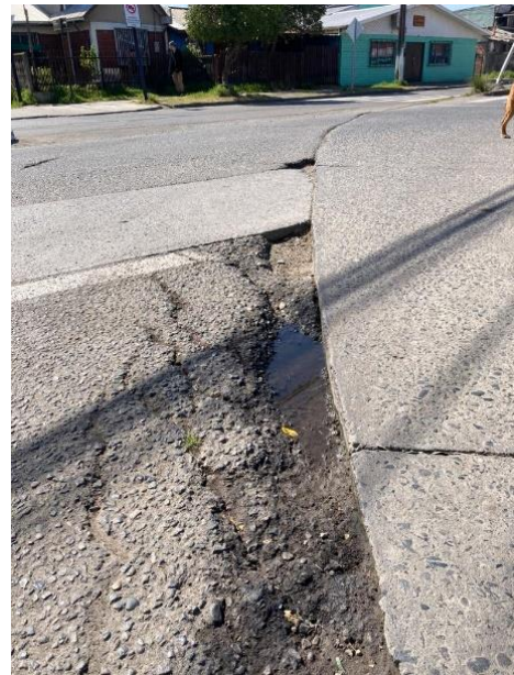
Bache Avda. Estación 7 , 6.00x1.00m. Intersección Avda. Estación – O. Jara Wolff. (11.00m 2 ).
