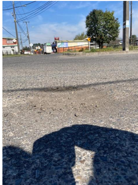
Bache Avda. Estación 5 , 1.00x1.00m. Intersección Avda. Estación – O. Jara Wolff. (1.00m 2 ).
