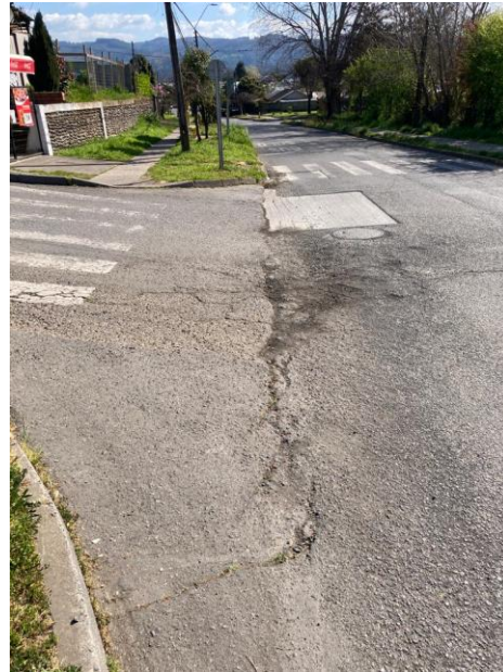
Bache A. Alessandri , 3.00x5.00. Intersección Calles A. Alessandri-Las Rosas (15.00m 2 ).
