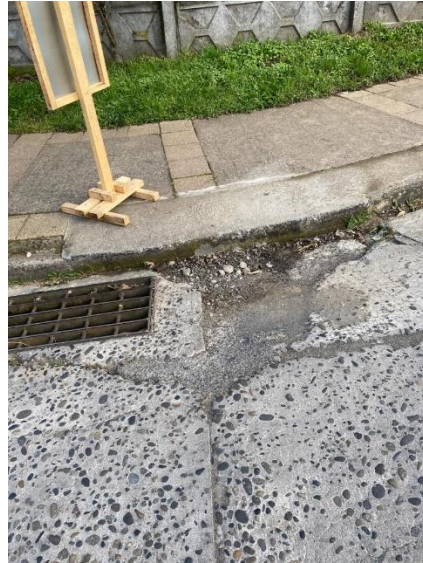
Bache intersección Freire-Lastra , 2.00x2.00m (4.00m 2 ).
