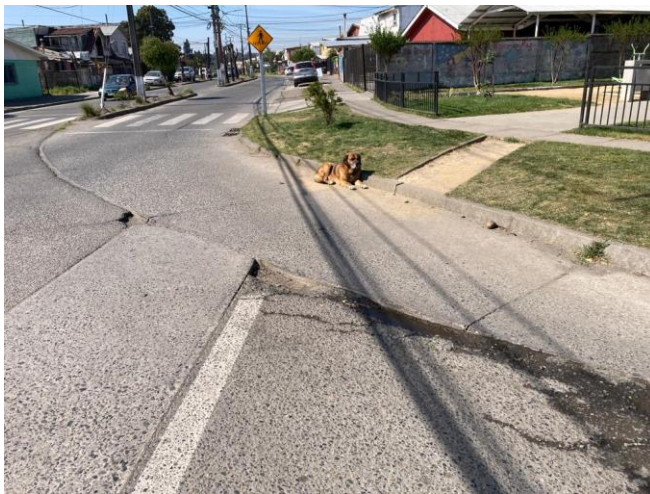
Bache Avda. Estación 7 , 6.00x1.00m. Intersección Avda. Estación – O. Jara Wolff. (11.00m 2 ).
