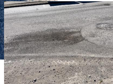
Bache Avda. Estación 6 , 2.00x2.00m. Intersección Avda. Estación – O. Jara Wolff. (4.00m 2 ).
